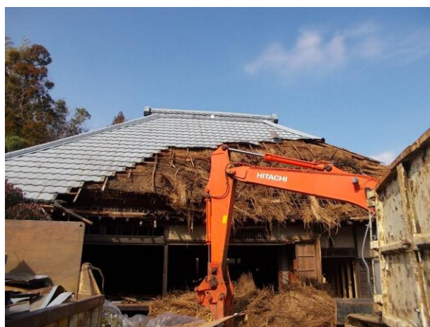
※解体される古民家（千葉県成田市）
